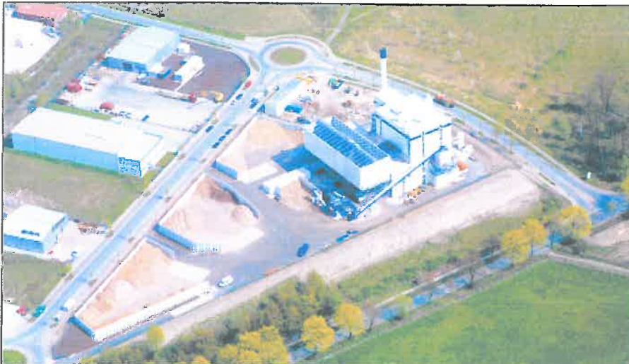
Referenzobjekt der Recklinghäuser Ökotech GmbH ist das Biomasse-Heizkraftwerk im Gewerbegebiet König Ludwig 4/5, wo mittels Verfeuerung von Gebrauchsholz Strom und Wärme erzeugt werden. Bild: gutzeit-luftbild
