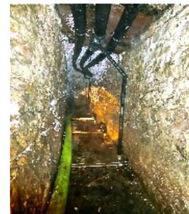
Nach Einbau Wärmetauscher und Zwischenmediumsleitungen
